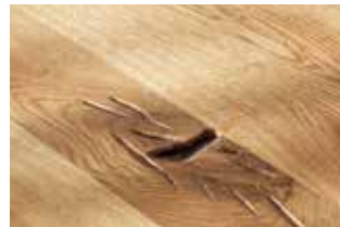
Offene Äste/Risse ausgeschliffen
